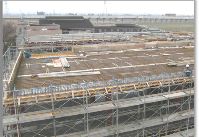
(屋上コンクリート打設準備:レインボ-屋上から撮影)
