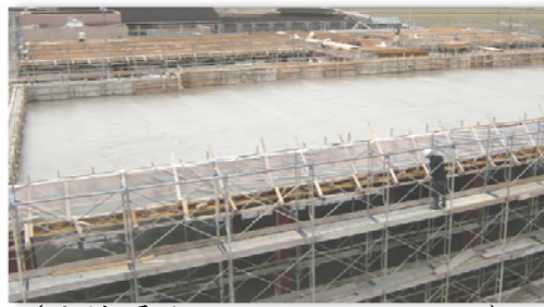
(北棟屋上:3/9レインボー屋上から撮影)
