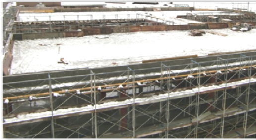
(北棟屋上:3/11は、雪が積もりました。)
