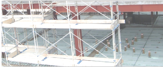
(南棟1Fフロアに断熱材敷設:しらいわ苑デイベース屋上から撮影)
