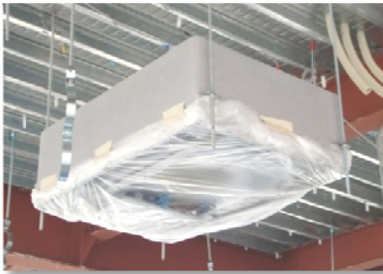
(共同生活室の天井)
