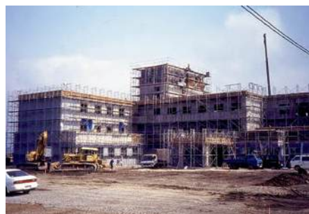
1992年/建設中の老人保健施設レインボー。多くの方々の善意が水橋の地に、形となっていきました。
