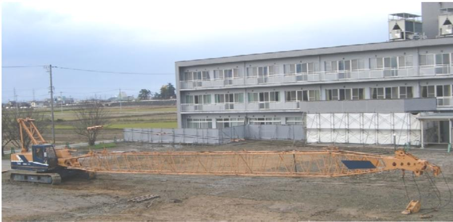
杭の打ち込みが始まります。トレーラー2台で大型重機と付属のクレーン部材が搬入され、組み立てられました。ようやく杭の打ち込み作業が始まります。地下四十メートル程の深さまで、五十二本打ち込みます。大地震や地面の液状化が発生しても、建物がびくともしないようにするための重要な工程です。杭が長く、機械も大型のため、危険度が高い工事です。安全かつ順調に作業が進むことを願います。
