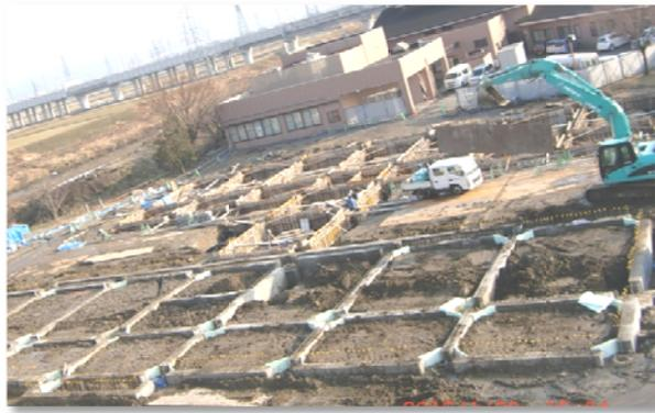
電気、設備の地中配管の据え付け埋設工事(左写真( )部分)が行われ、この工事が完了したところにコンクリートを流し込みます。基礎が固まったところの埋戻しも始まっています。2月初旬まで続きます。その後、いよいよ鉄骨材の据え付け、組み立てが始まります。その時はまた、大型の運搬車両の通行や大型クレーンの稼働などが始まります。あらためて細心の注意を払って工事を進めていただくことを要望しています。
