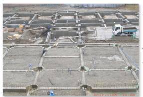
す。今週末から玄関タイル部分の工事が始まり、送迎車がデイサービス玄関からつながる渡り廊下の工事も始まりま 圧と工程が進んでいます。柱となる鉄骨材の据え付け位置がた。北棟(レインボー側)と同様に順次埋戻し、砕石敷き、転 屋根下に入れなくなります。今週末から玄関タイルが 明確になってきています。 惑をお掛けすることになりますが、ご協力をお願い致します。 。雨の日など利用者の皆様にご迷
