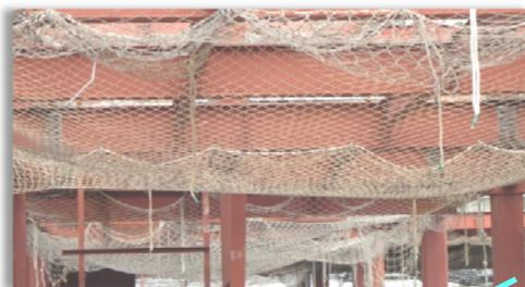
工事作業員の皆さんの安全確保のために、落下防止用の網が設置され、安全帯の装着の徹底が行われています。
