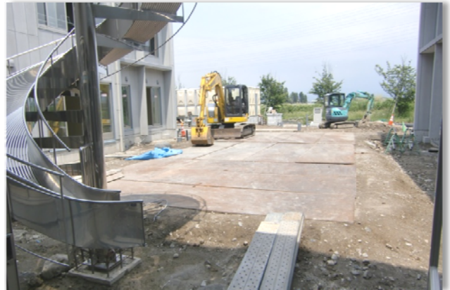
(東側中庭予定地:中央廊下から撮影)
