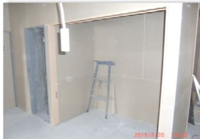
(南棟1階収納スペース)
