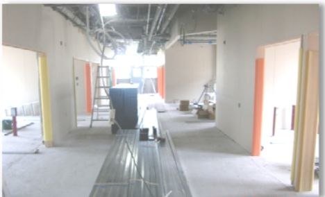
(南棟1階東側ユニット)
